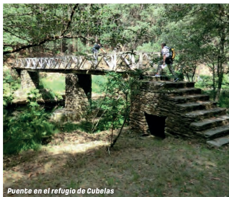
Puente en el refugio de Cubelas
