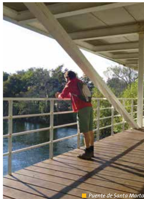
Puente de Santa Marta
